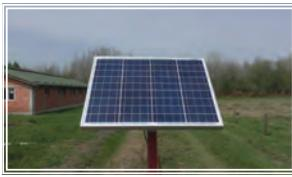
Slika 16. Solarni panel za punjenje akumulatora
